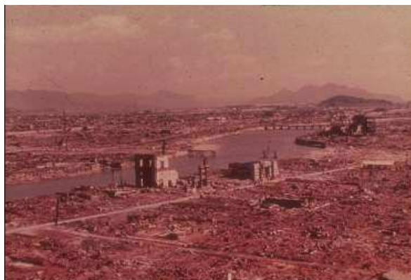
Figura 9. Hiroshima distrutta, agosto 1945
