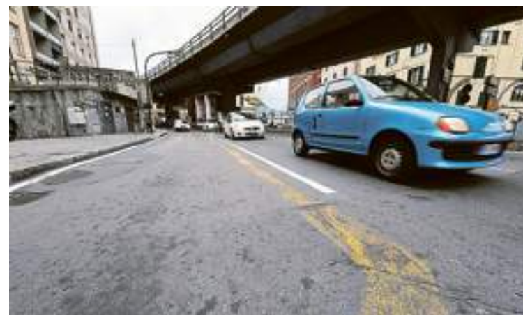
La segnaletica rifatta a metà può trarre in inganno
