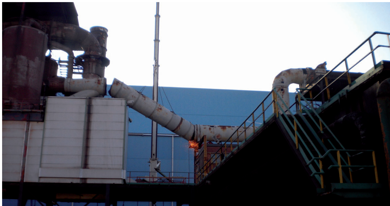
DEMOLIZIONE FINALE Il momento in cui viene smantellata l'area «elettrofiltri» nell'ex stabilimento Ilva
